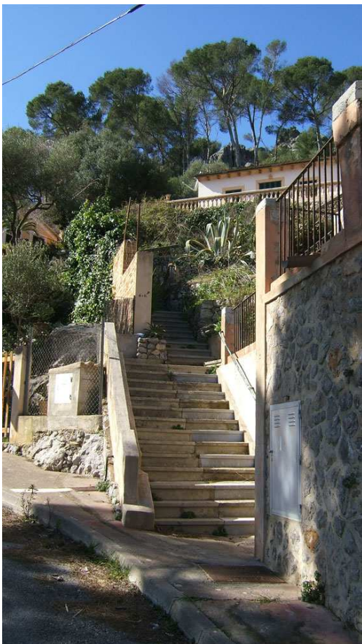
F.1 Vista de l'escala des del carrer.
