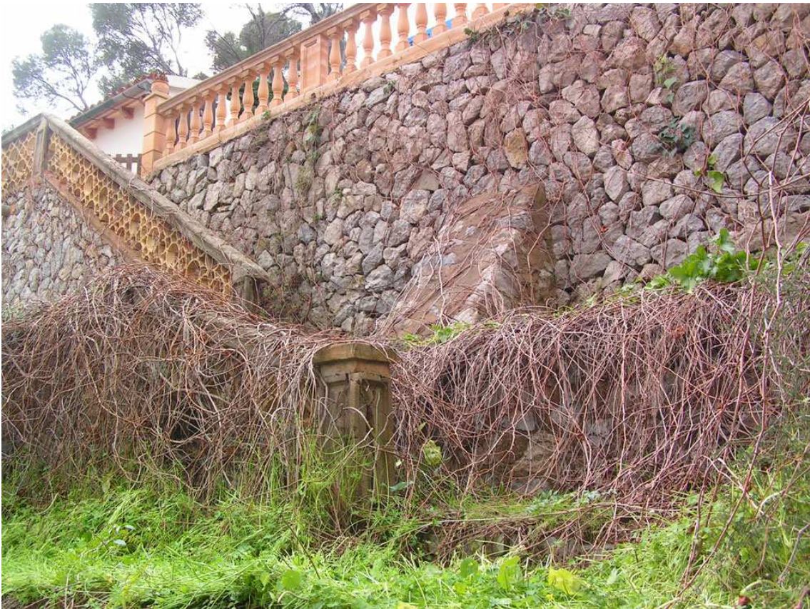
F. 4 Vista de l'escala de baixada sense utilitzar
