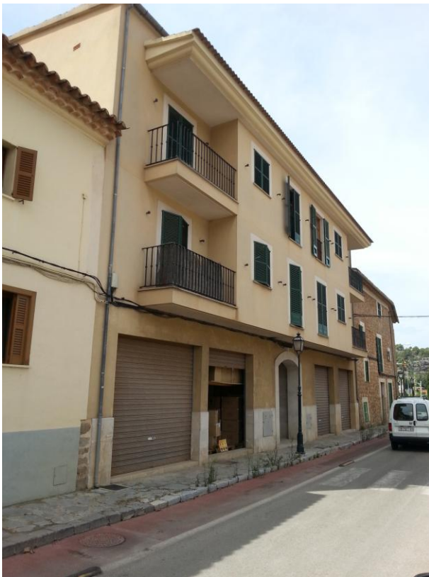
Edifici existent situat al nº 101
