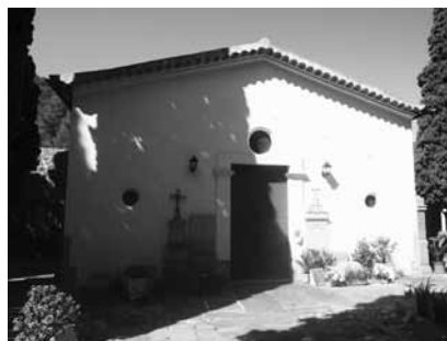
Façana de la capella del cementeri.
