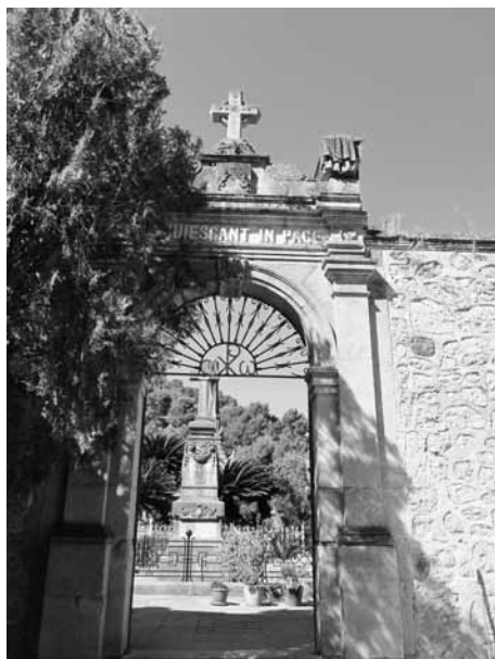
Portal que dona a la terrassa del fosser dissenyat per l'arquitecte Joan Guasp i Vicens.
