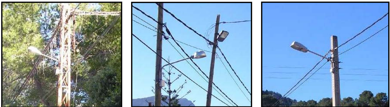
Figura 12.2.10. Luminàries sense cubeta difusora del Port de Sóller
