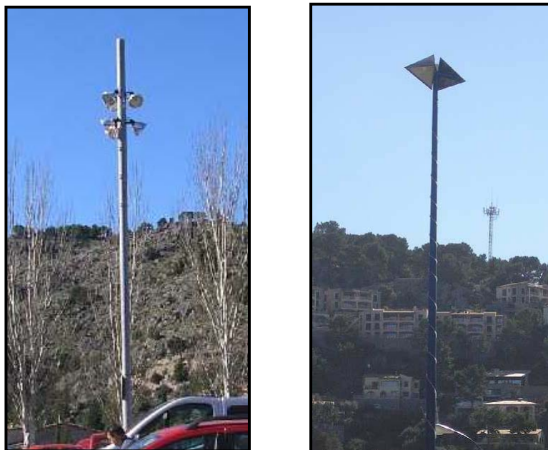
Figura 12.2.11. Luminàries sense cubeta difusora del Port de Sóller
